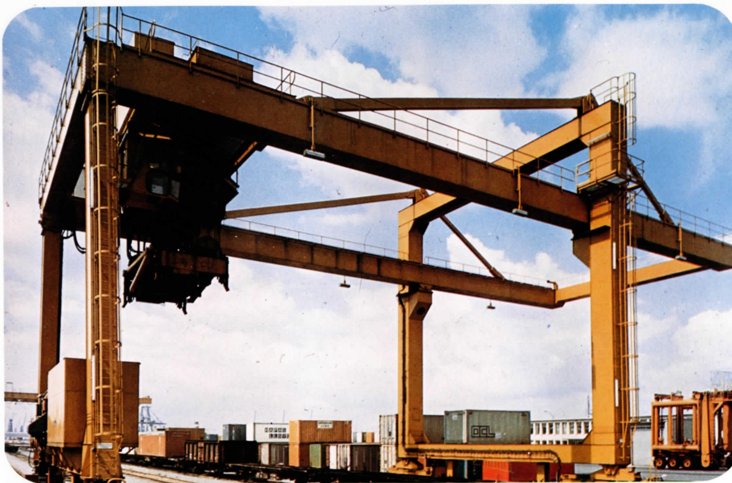
Container handling crane Portique pour manutention de conteneurs Laadbrug voor containers
