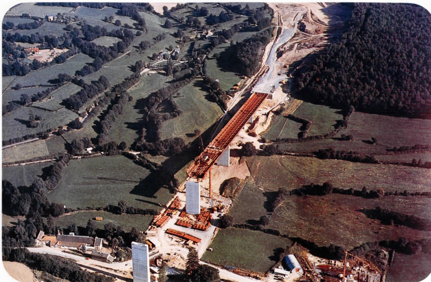
Highway structural steel bridge of Polleur Viaduc d'autoroute à Polleur Autosnelweg viadukt te Polleur
